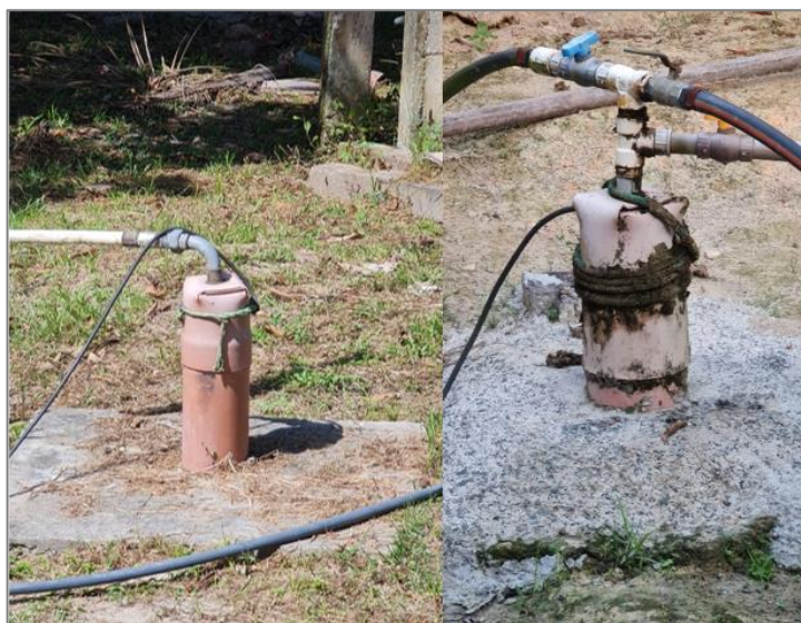
Figura 6. Instalação de bombas para poços.
