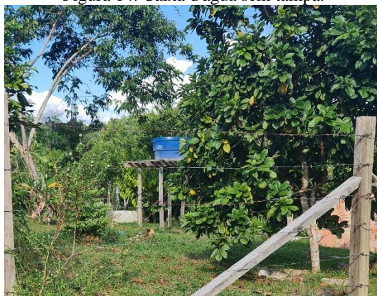
Figura 14. Caixa d'água sem tampa.
