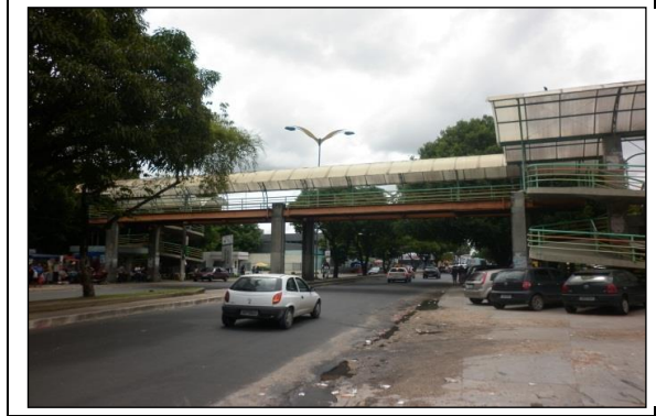
Figura 5 – Passarela da av. Carvalho Leal. Coberta e acesso via rampa.
